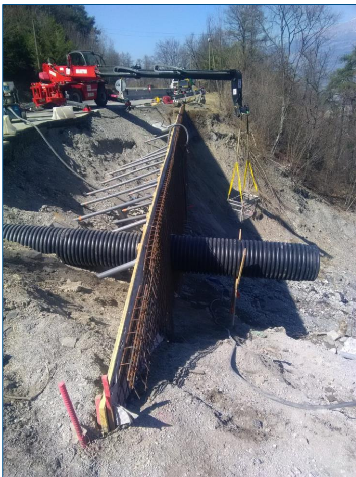
Figure 5: Exemples de référence pour les travaux de cloutage avec coffrage perdu
